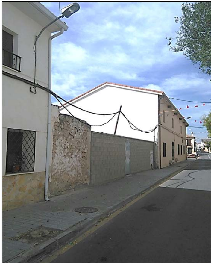
Zona de la tala DESPUÉS de la intervención.
