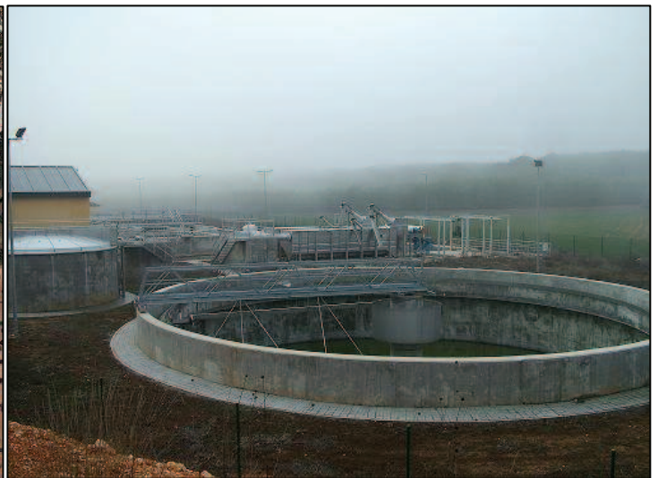
Depuradora de Pioz (17/01/2011)
