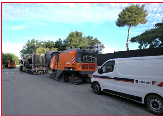
Maquinaria, lista para iniciar los trabajos.
