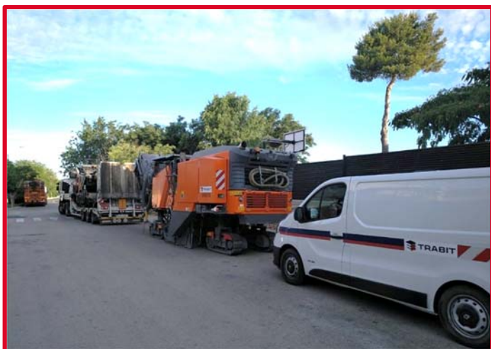
Maquinaria, lista para iniciar los trabajos.
